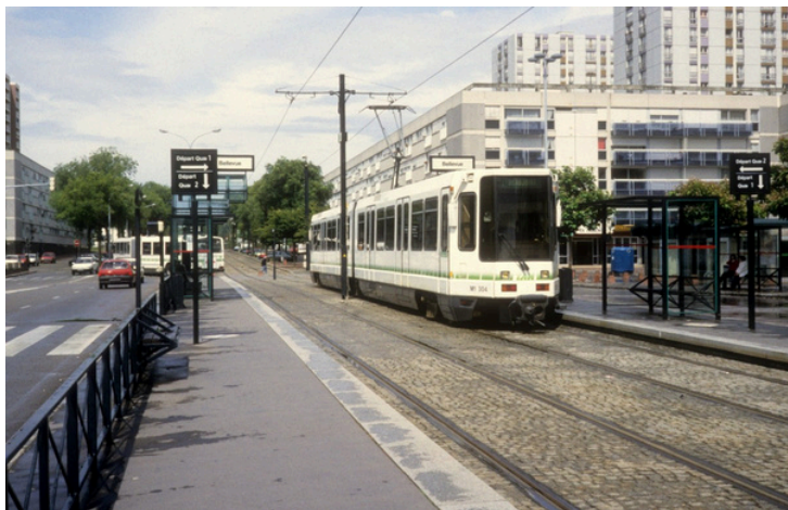
• Tramvaiul "TFS" din Nantes, Franța 1992.
